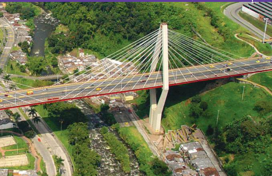
Viaducto César Gaviria Trujillo
