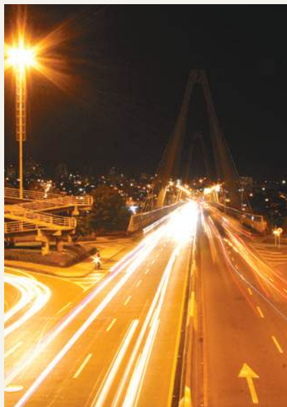
Vista nocturna viaducto César Gaviria Trujillo
